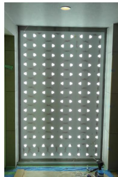
6500K LED取付ピッチ150mm アイスオニキス(パネル内距離≒100mm)
