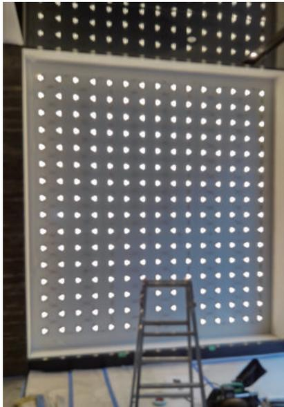
3000K LED取付ピッチ150mm イエローオニキス(パネル内距離≒100mm)
